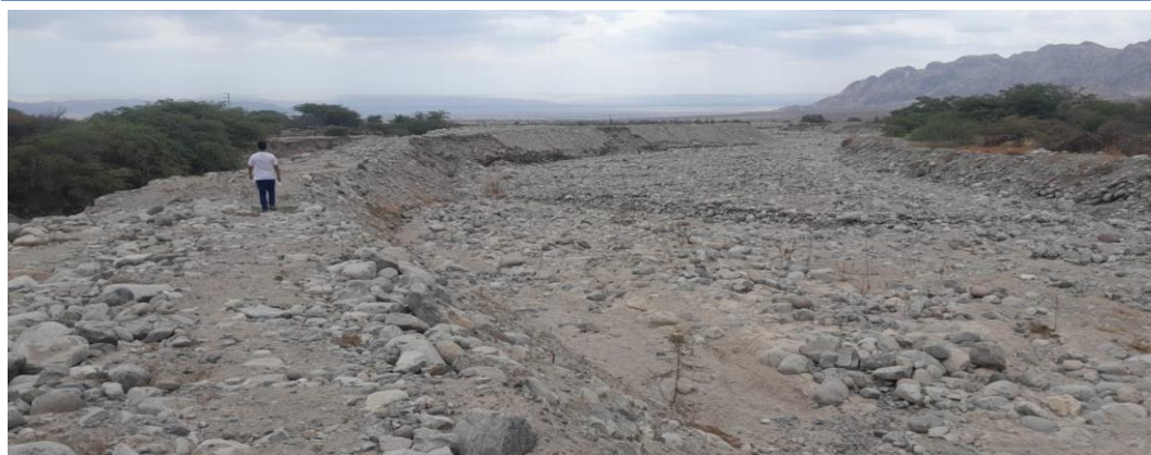
IMAGEN 02: SE MUESTRA QUE CUENTA CON UN DIQUE CON EROSIONES DEBIDO A LA FALTA DE UNA ESTRUCTURA PERMANENTE
