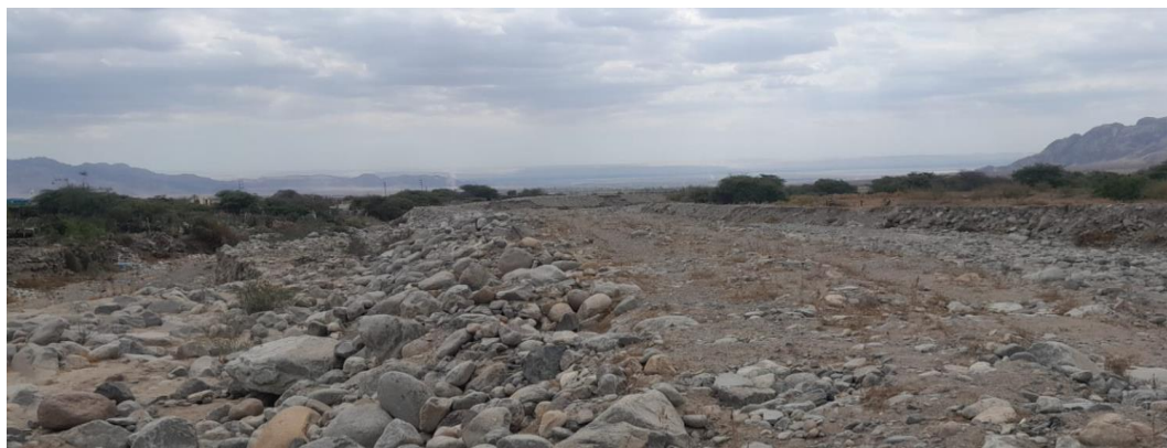
IMAGEN 01: SE MUESTRA EL ESTADO ACTUAL DEL CAUCE DEL RIO TINGUE COLMATADO TODO EL TRAMO NO SE CUENTA CON OFERTA DE ROCA DE CANTERA POR LO QUE SE PROPONE CONSTRUIR UN MURO DE CONCRETO ARMADO
